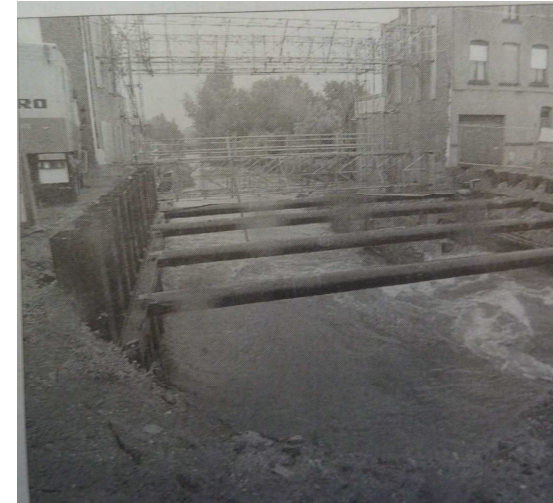
Avenue Vyncke, le sol continue à s'affaisser. Les pluies diluviennes et le poids du camion ont aggravé la situation.
